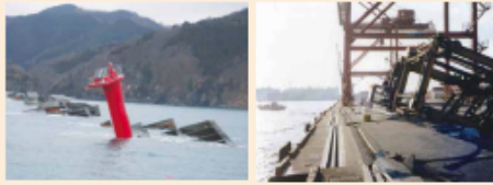
東北地方太平洋沖地震の被害
