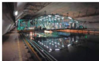
400m 吹航水槽
