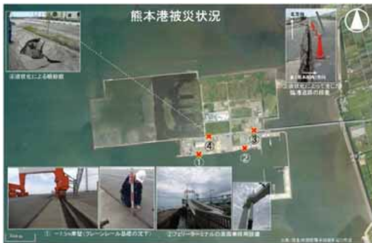
図 1. 3. 3 熊本地震での熊本港の被災状況
