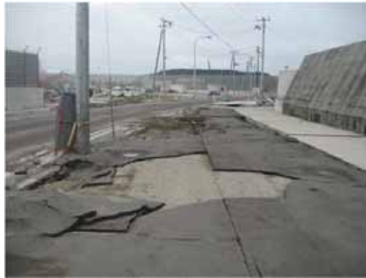
図1. 3. 26 仙台港の被災調査
