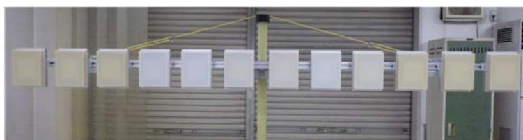
図 1.4.23 改修後の空中線素子
