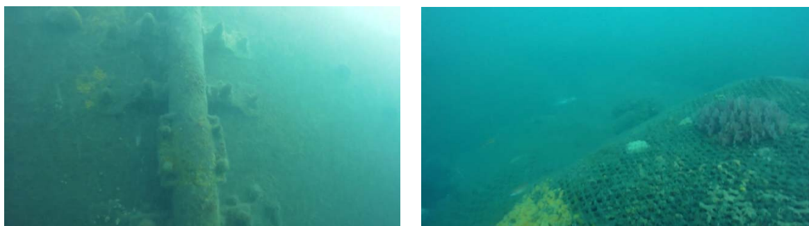
図8 「AUV-ASV 連結システム」の AUV による海中撮影映像 (風車塔西側側面のケーブル保護管(左)、風車塔東側海底付近の洗堀防止用フィルターユニット(右))
