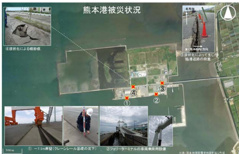
熊本港の被災状況
