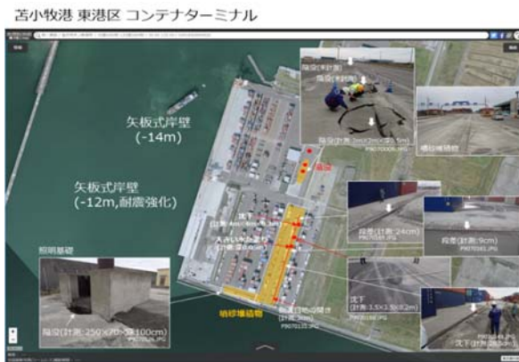
【苫小牧港での被災調査】
