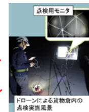
ドローンによる貨物倉内の点検実施風景
