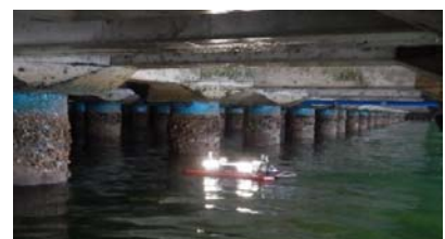
【ROVによる棧橋点検状況】
