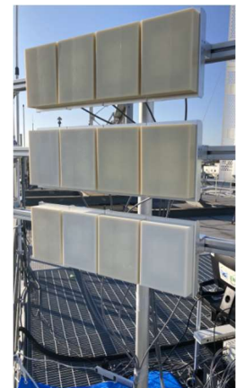
(c) 条件 3: 屋外・改修有り
