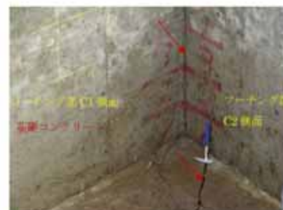
被災例(3号機(ひび割れ状況))
