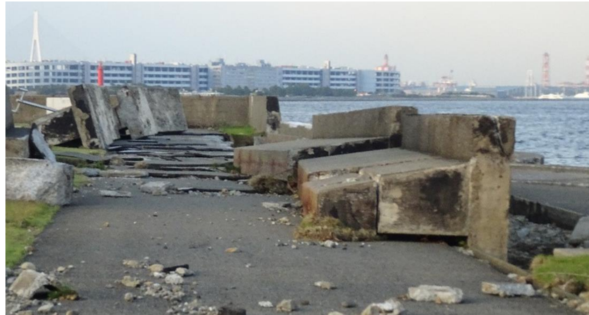
【台風1915号による護岸の被災】
