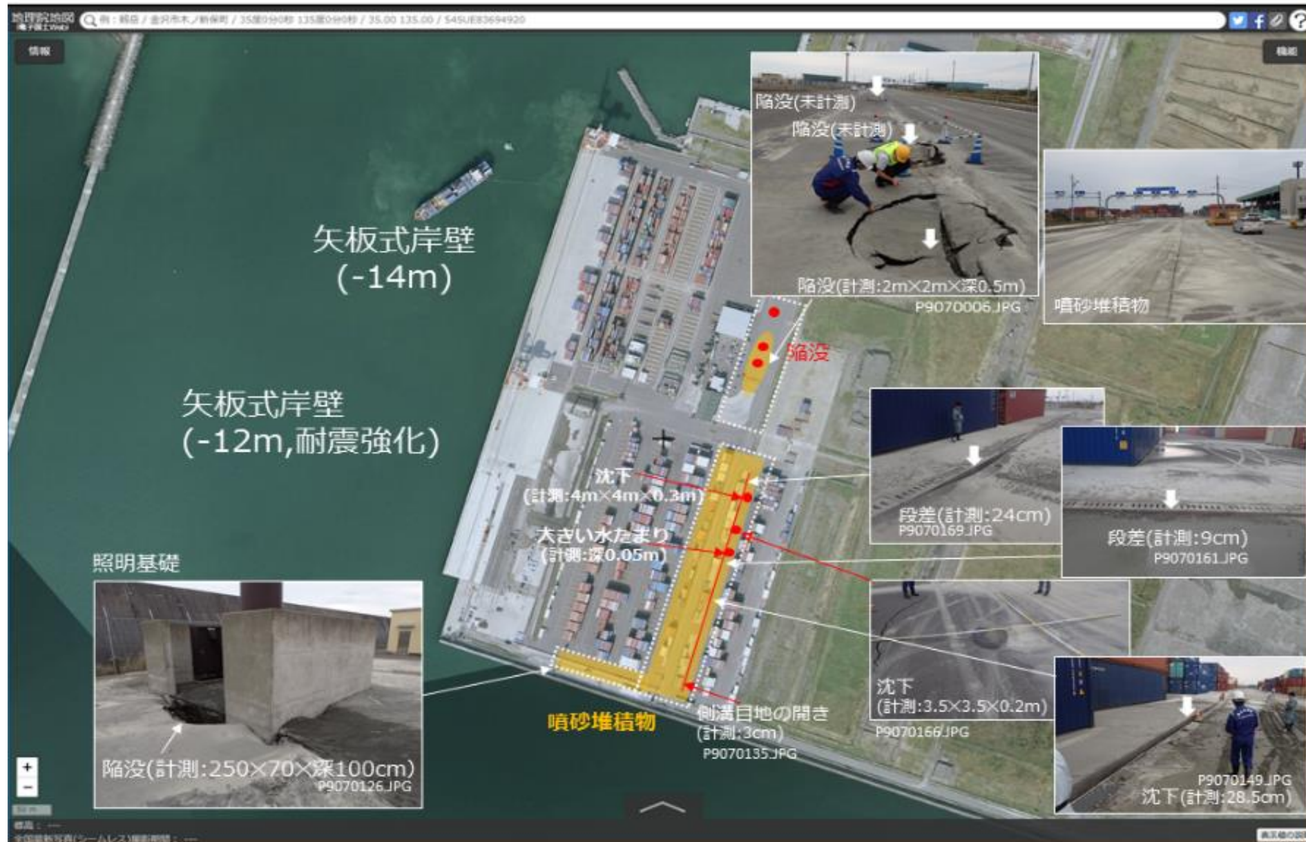
【苫小牧港での被災調査】
